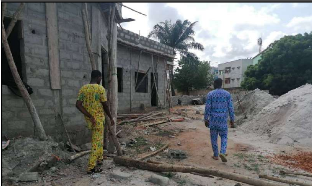
Août 2020-Bâtiment Prêt
